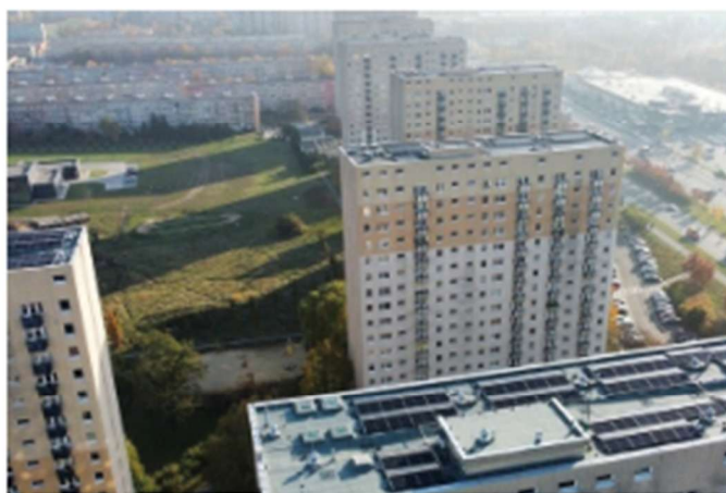
Na dachach 17-piętrowych budynków Poznańskiej Spółdzielni Mieszkaniowej Winogrody działa instalacja fotowoltaiczna złożona ze 1148 paneli słonecznych. Rocznie ta rozproszona elektrownia PV produkuje 350 MWh energii.
