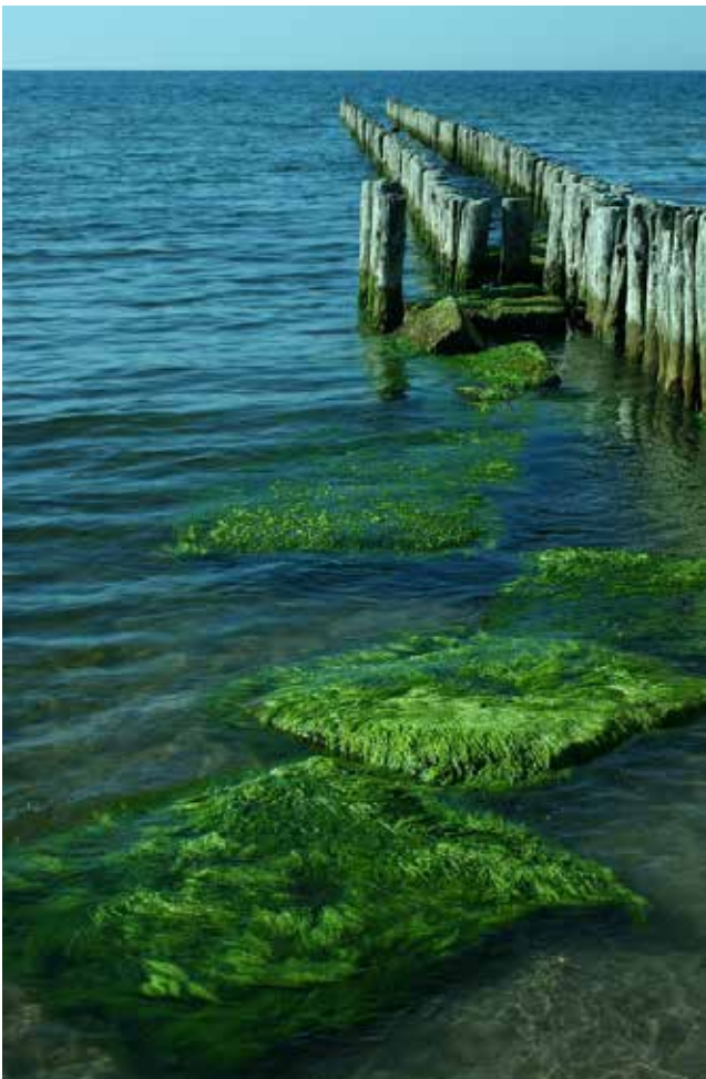
Bałtyckie falochrony pełnią kluczową rolę w ochronie linii brzo-gowej. Na zdjęciu falochron w Mielnie.
