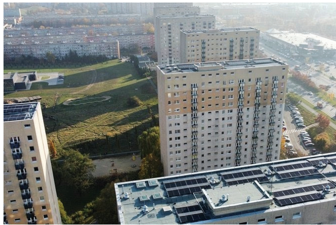
Na dachach 17-piętrowych budynków Poznańskiej Spółdzielni Mieszkaniowej Winogrody działa instalacja fotowoltaiczna złożona ze 1148 paneli solarnych. Rocznie ta rozproszona elektrownia PV produkuje 350 MWh energii. Fot. Planet Partners
